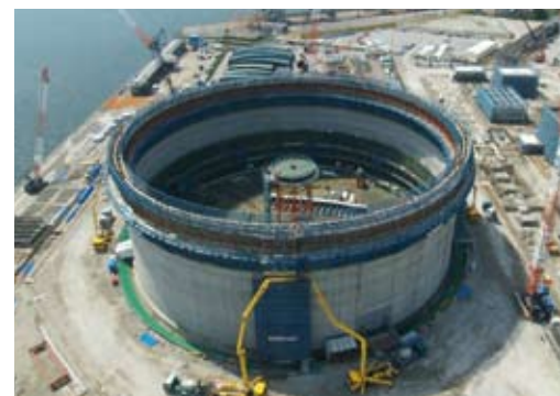
Construction of LNG tank
