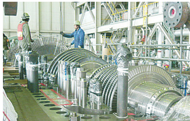
高中圧タービンローター取付状況
