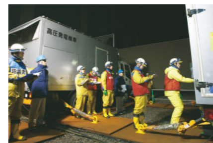
夜間での電源車による給電訓練
