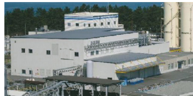
変圧器リサイクルセンター
