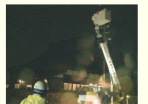
夜間の復旧作業
