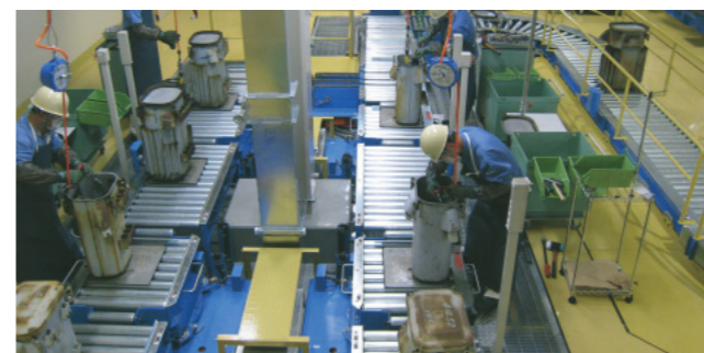
容器処理施設内の様子
