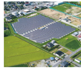
富山太陽光発電所
