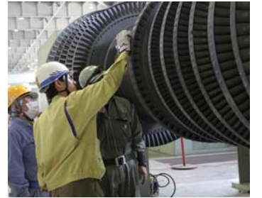
火力発電所タービン点検
