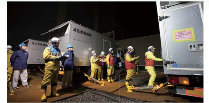
電源車による給電訓練
