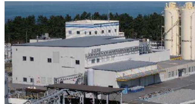
変圧器リサイクルセンター
