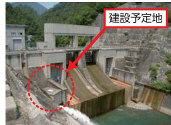
北又ダム発電所建設予定地
