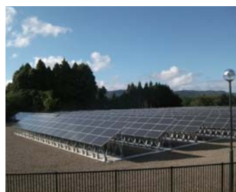
珠洲太陽光発電所の建設工事
