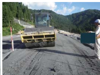
道路 (国道) 軽量盛土材
