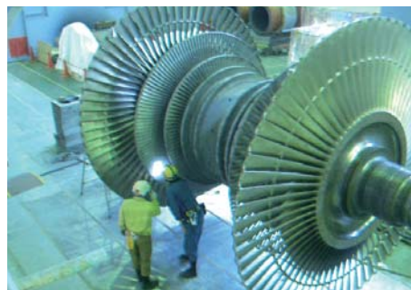
火力発電所定期点検の様子
