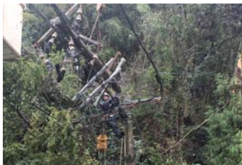
倒木処理、被害設備の撤去および電柱新設
