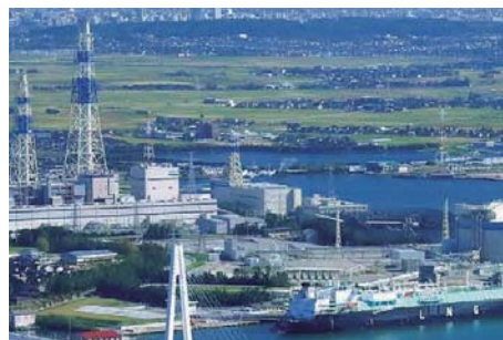
<2018年>富山新港火力発電所LNG1号機運開
