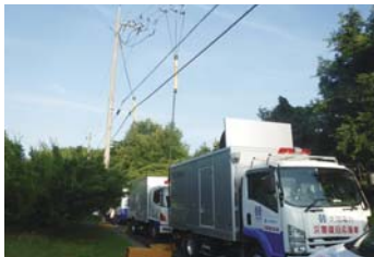
高圧発電機車による仮送電
