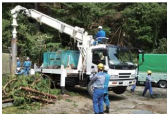
倒木処理、被害設備の撤去および電柱新設
