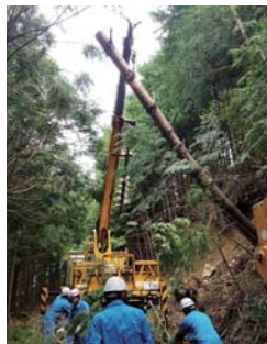
倒木処理、被害設備の撤去
