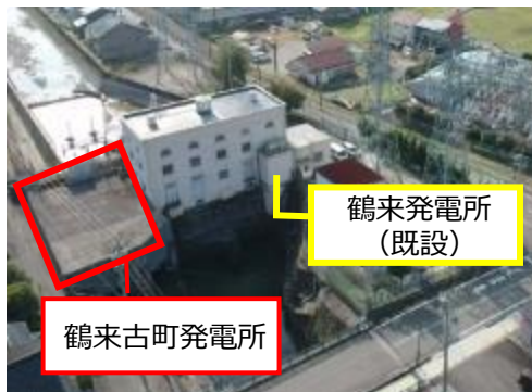
鶴来古町発電所
