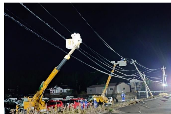
応急復旧工事（電柱傾斜改修）
