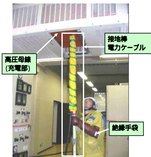
第 1 図 人工地絡試験風景
