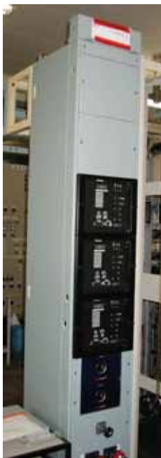
第9図 フィールド試験状況
