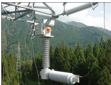
第4図 塔上開閉装置全体図（1相分）
