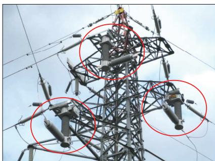
第3図 塔上開閉装置取付状態
