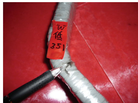
第3図 単体コイル絶縁破壊状況（破壊部位様相）
