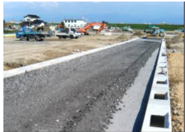
第 9 図 再生路盤材現場施工状況
