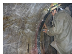
第16図 不動態化処理 (電解研磨)の状況
