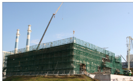
〔緊急時対策棟(建設中)〕
