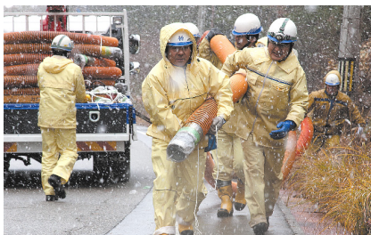
〔大坪川ダムからの仮設水路敷設訓練〕
