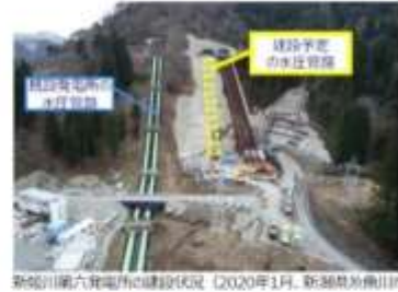
新姫川第六発電所の建設状況 (2020年1月、新380m級黒川川)
