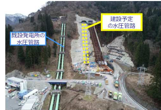
新姫川第六発電所の建設状況 (2020年1月、新潟県糸魚川市)
