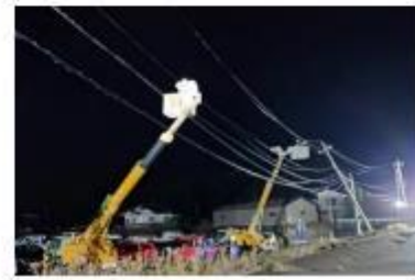
応急復旧工事（電柱傾斜改修）
