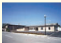
水橋西部公民館・地区センター
