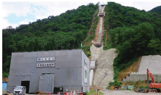
水圧管路～発電所本館工事状況
