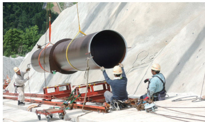
水圧管路工事状況
