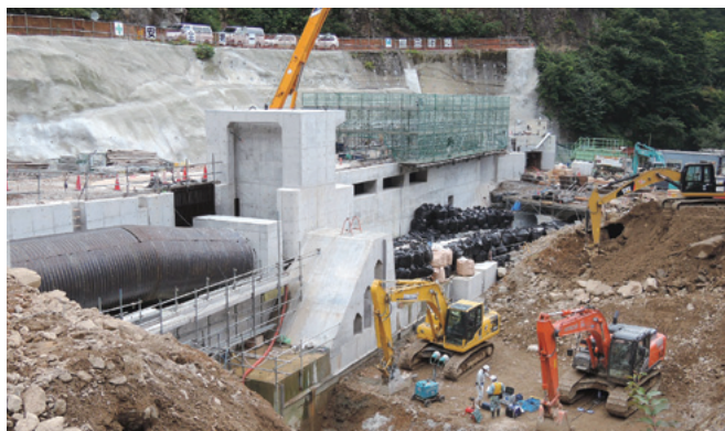
取水設備工事状況
