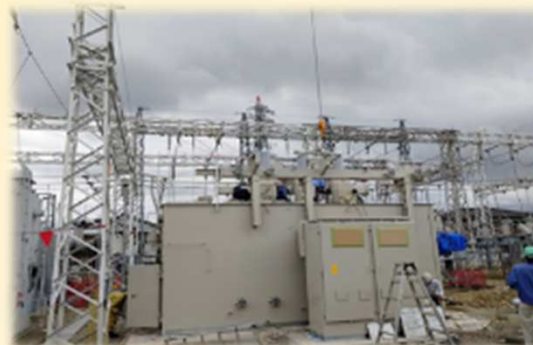
＜変圧器更新工事＞
