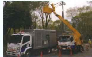
電源車による災害時の復旧作業
