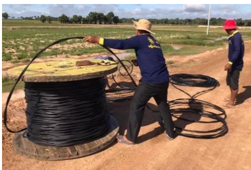
Sun-eee 社員による電線敷設作業の様子
