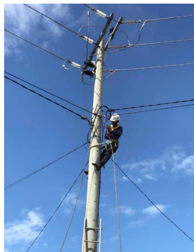
Sun-eee 社員による工事の様子
