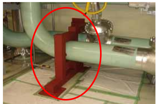
図 - 3 耐震裕度向上工事の概要
