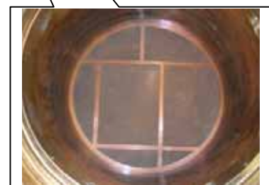
触媒（最下層） （排ガス再結合器上部より撮影）
