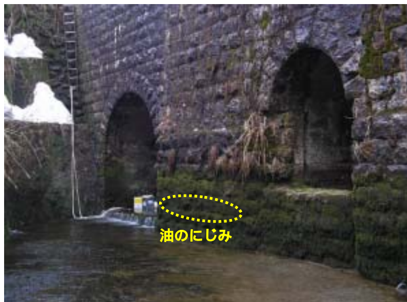
図 3 2号水車付近 本館側壁(放水路側)
