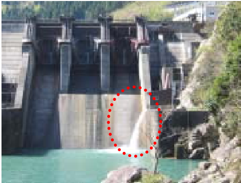
河川維持放流の状況(仏原ダム)
