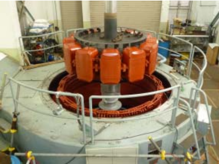
小見発電所 改修中の2号発電機
