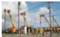
配電工事安全技能大会
