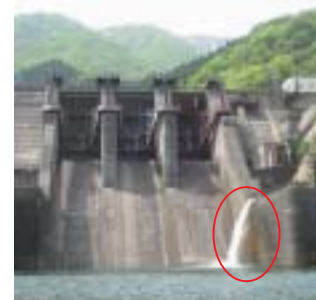
河川維持放流の状況(仏原ダム)
