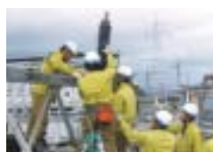
移動用設備設置訓練
