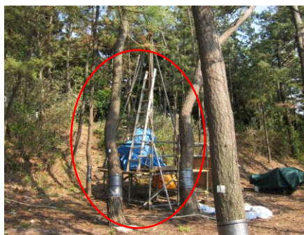
㊼防潮堤の構築 【ボーリング調査実施中】
