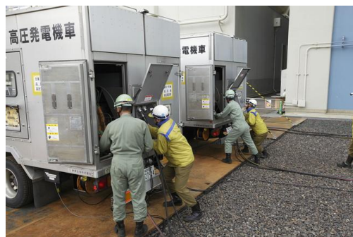
⑦-4緊急時対応訓練の実施 電源車による給電訓練
