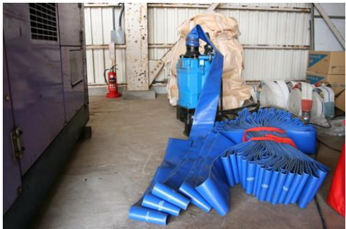
②④-2注水手段の強化・整備 水中ポンプ、ホース等の配備
