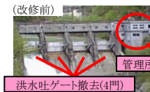
洪水吐ゲート撤去(4門)
