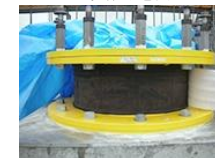
免震装置（積層ゴムアイソレータ）
