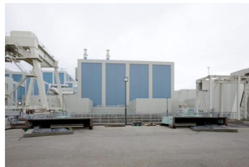
㊽取水槽・放水槽廻りへの防潮壁の設置 【構造設計中】
