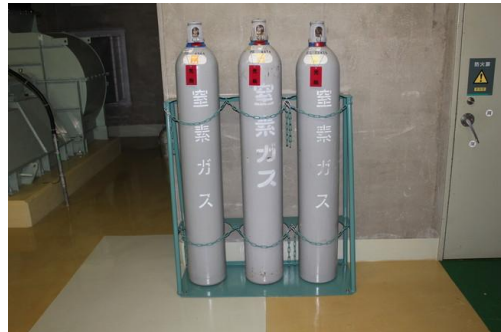
③格納容器ベントの信頼性向上 予備ポンプ(22本)の追加配置
