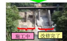
施工中 改修完了
