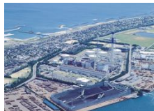
富山新港火力発電所
