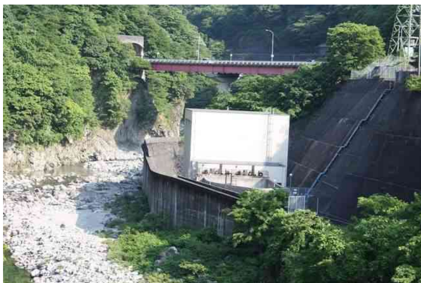
新猪谷発電所 本館
