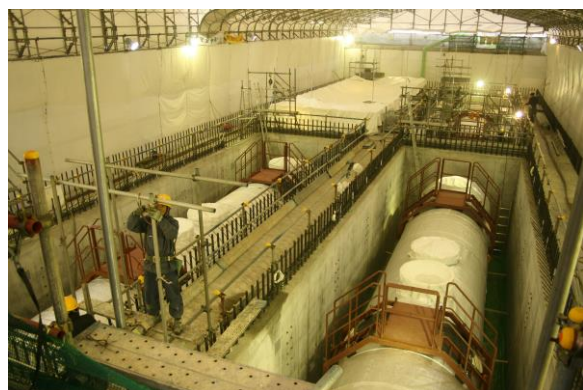
2号機原子炉建屋北側の標高 21m地点に建設中 （写真：シートに覆われた軽油タンク。1基 70kl, 4基。11月末現在）
