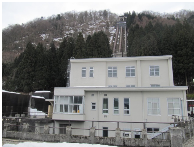
五条方発電所 本館
