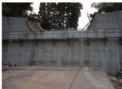
石川県 砂防ダム工事
