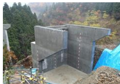
福井県 橋台工事
