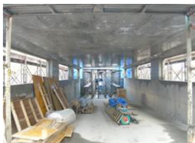
富山県 地下道工事
