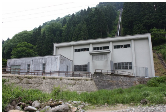
上打波発電所 本館
