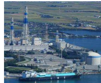
<2018年> 富山新港火力発電所 LNG1号機運開
