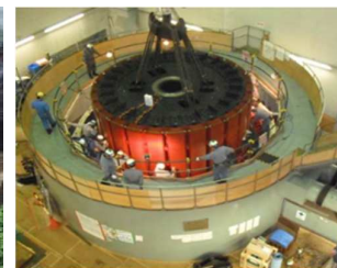
水車発電機のオーバーホール
