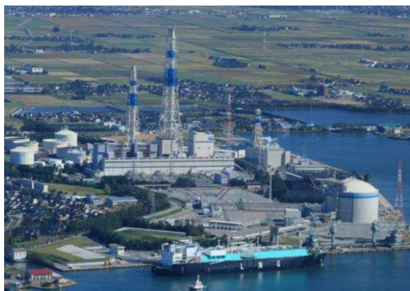
[富山新港火力発電所]
