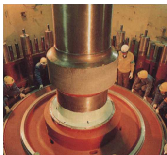
有峰第一発電所水車オーバーホールの様子
