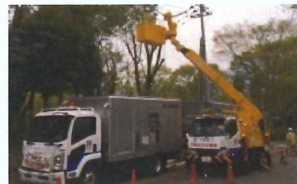
電源車による災害時の復旧作業
