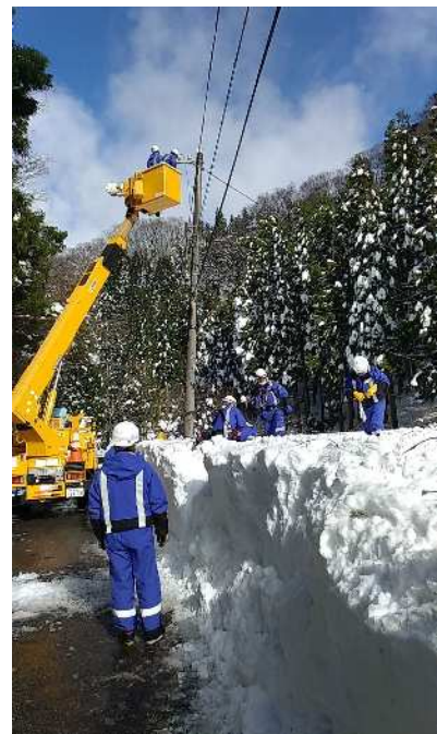
停電復旧作業
