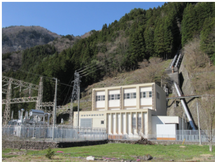
栃尾発電所 全景
