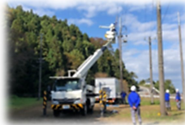
停電復旧作業
