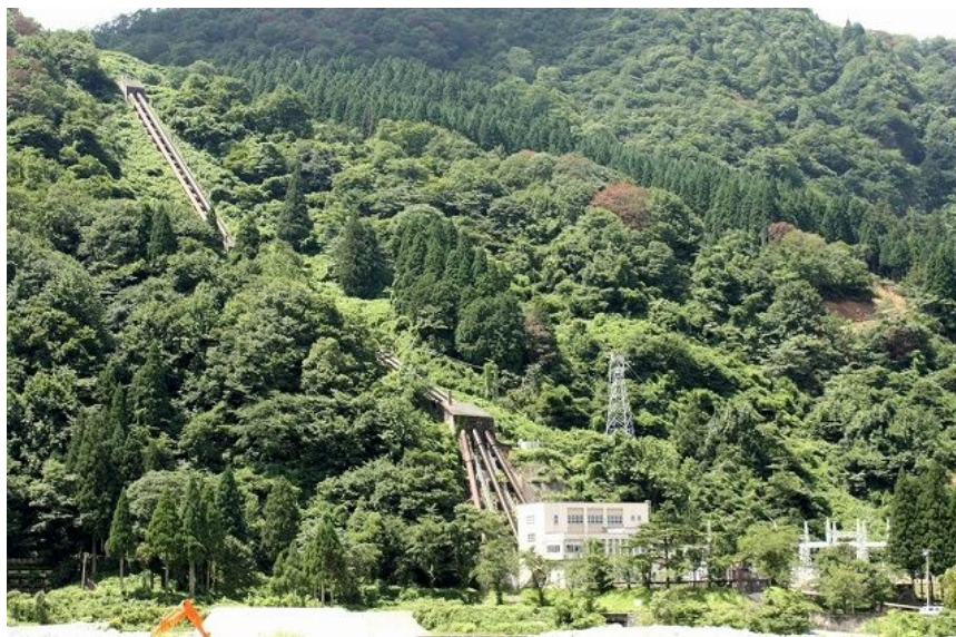
伊折発電所 全景
