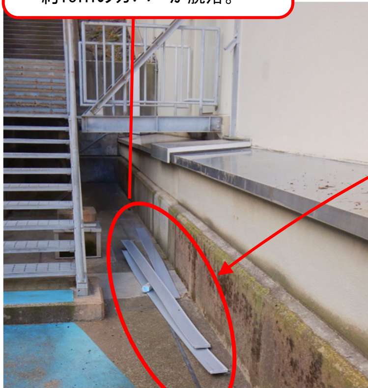
1, 2号機廃棄物処理建屋エキスパンション・ジョイントのカバー脱落
