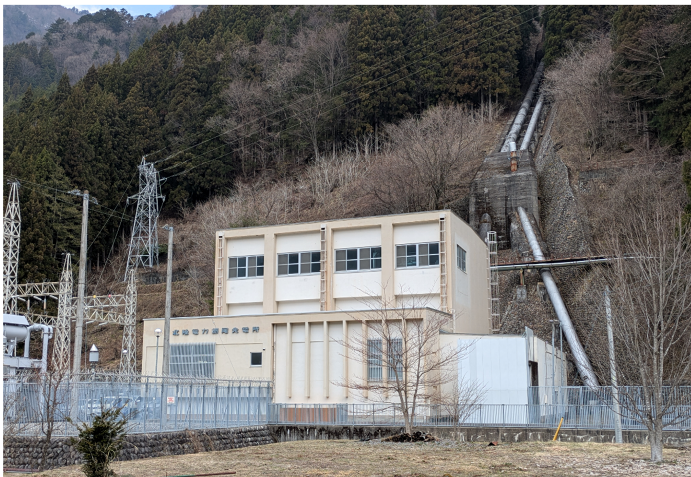
栃尾発電所 全景
