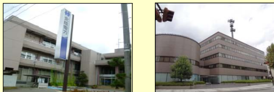
原子力本部ビル 又は 金沢電気ビル (代替場所)
